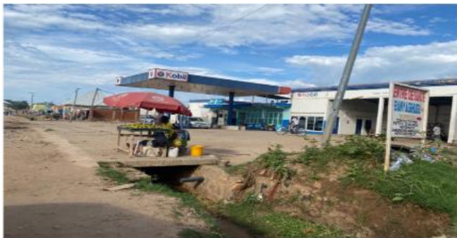
Photo 3: Activités commerciales impactées par les travaux le long de la RN3
