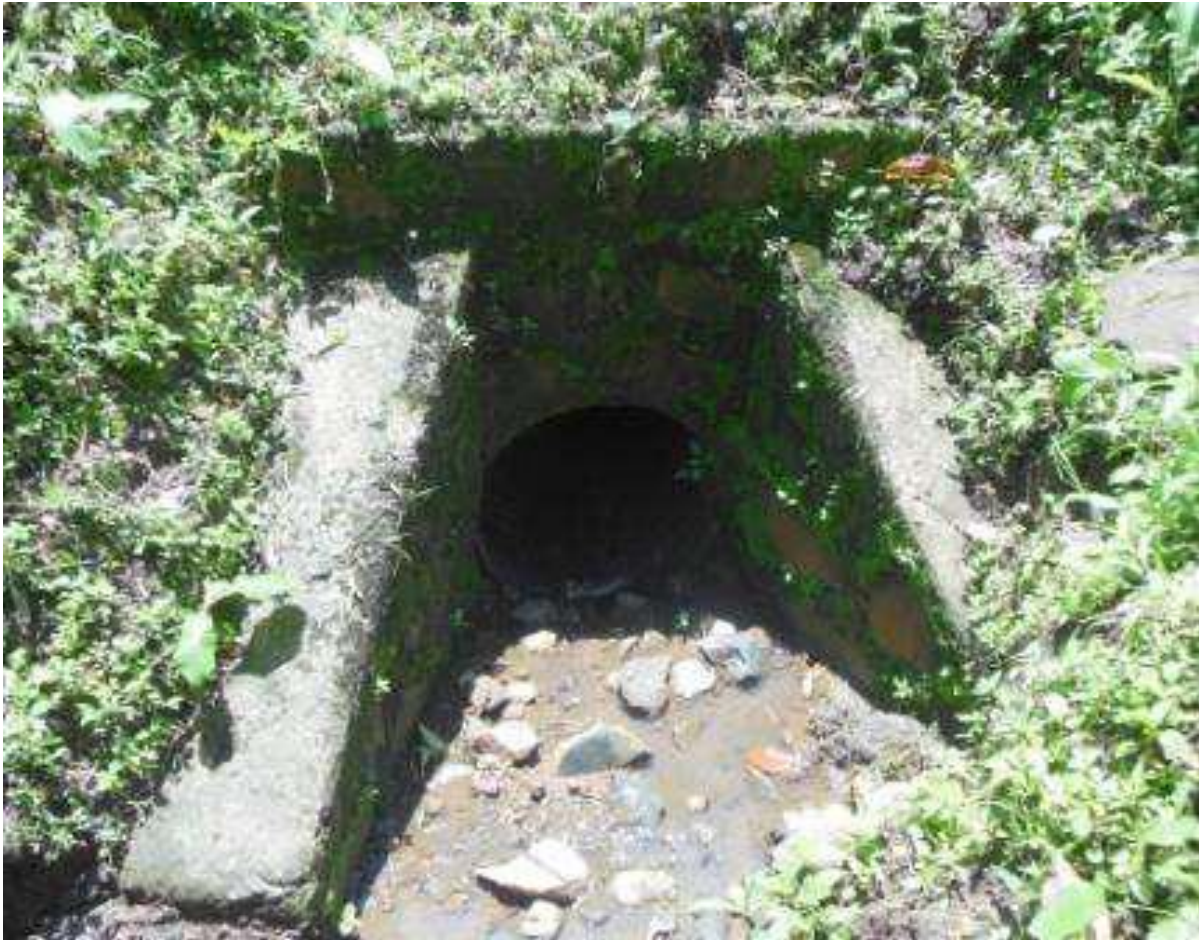
Ouvrage hydraulique nécessitant un redimensionnement – Buse métallique sous dimensionnée et usée
