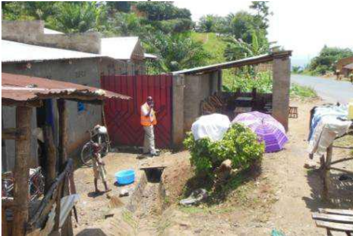
Construction sur un caniveau – maison à démolir
