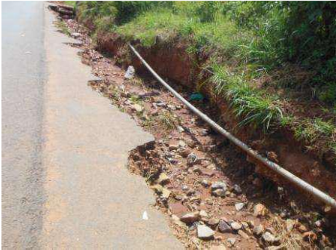
Réseau d'eau exposé par l'érosion du caniveau
