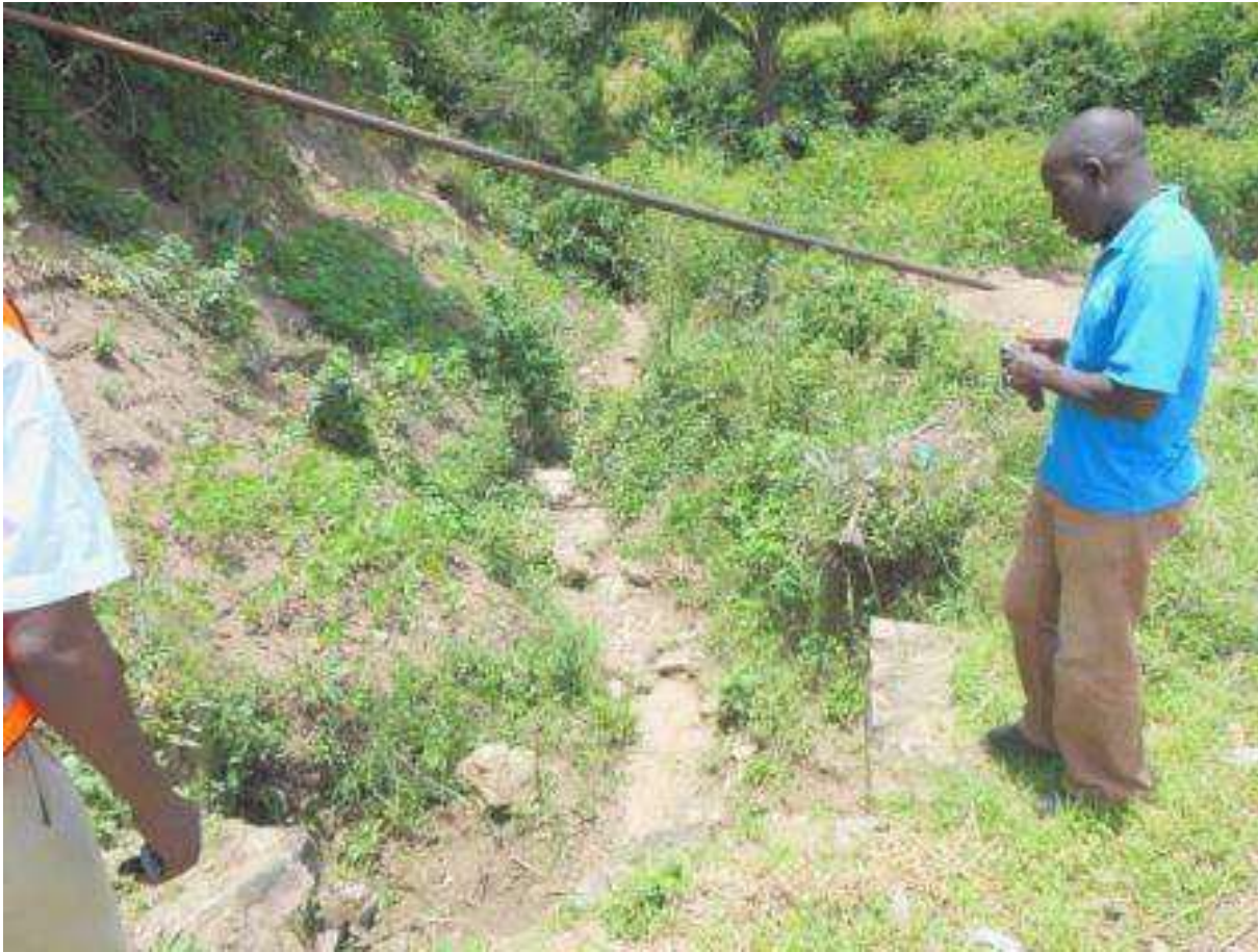
Exutoire des eaux érodé – nécessité d'une descente d'eau maçonnée
