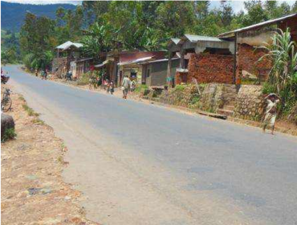
Construction dans l'emprise de la route- village Mageyo dans la commune Mubimbi
