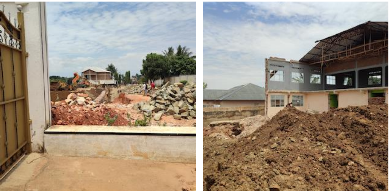
Photo 9 - Partie avec maisons complètement détruites et vestiges d'un étage à Gikungu
