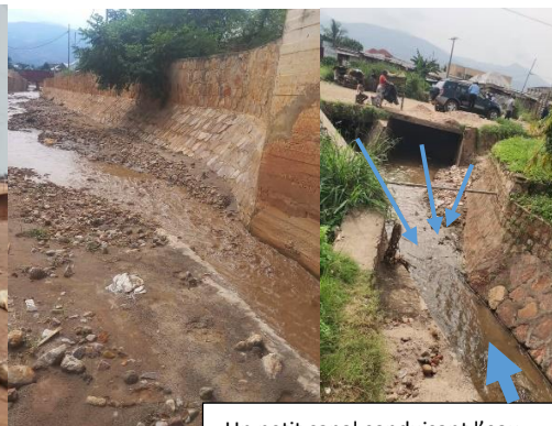
Un petit canal conduisant l'eau provenant des quartiers Kamenge, Gasenyi et Gattunguru
